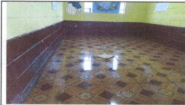
Foto 3: Sustrucción de cemento líquido por piso cerámico
