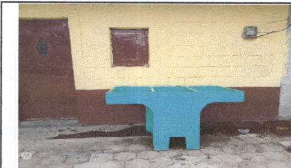
Foto 5: Sustrucción de pila de cemento de dos lavaderos
