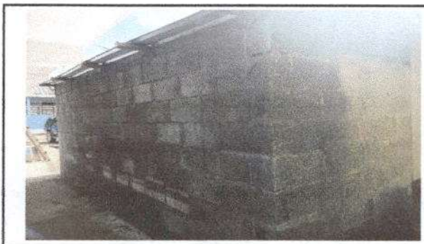
Foto 6: Aplicación de sabieta en muro de contención
